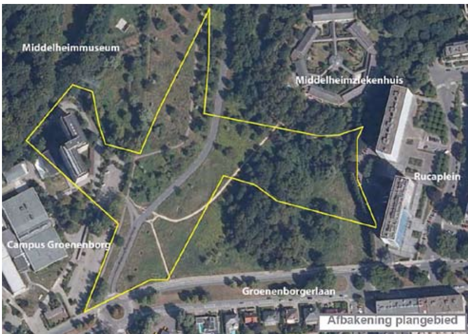
Situering Buurtpark Groenenborg: alles wat binnen de 'ster' valt, met uitzondering van het bestaande gebouw met parking in het linkse deel van de ster. Onder de ster, langs de Groenenborgerlaan verdwijnt het bos (intussen deels gekapt) voor de realisatie van een uitbreiding van de Universiteit en van serviceflats en een kinderdagverblijf van de Stad
