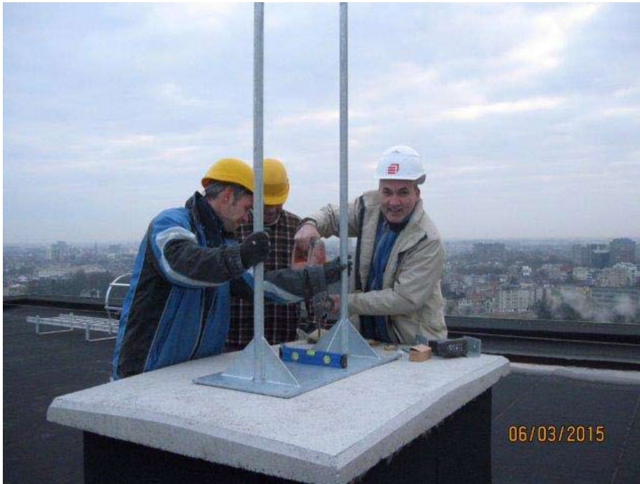
1. Arbeiders van Antwerpse Bouwwerken plaatsen de slechtvalken-zitpost op de groene Silvertoptoren (6.3.2015, Foto: Peter Walraeven)
