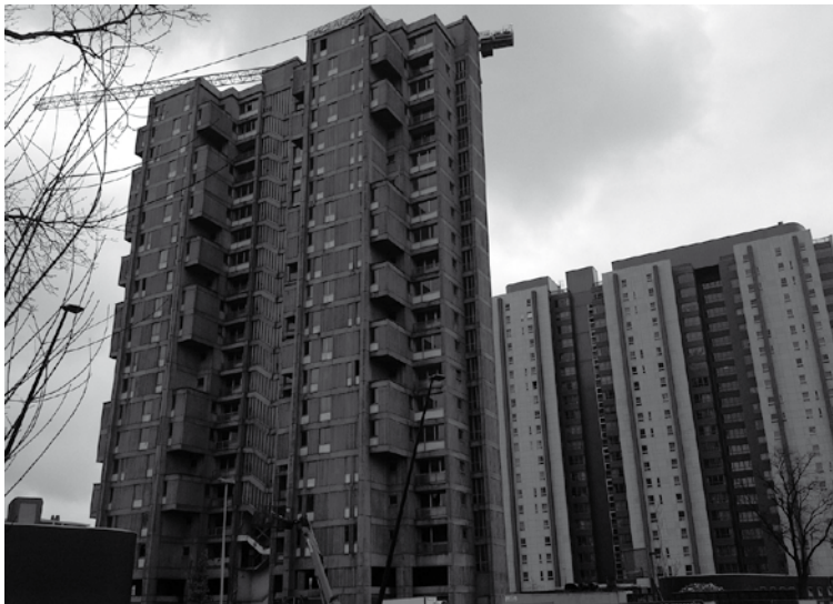
De slechtvalken schijnen zich niet te storen aan de torenkraan van de werf. De aannemer Peter is ondertussen zelf ook aan het valkenspotten! Foto: Joris Van Reusel
