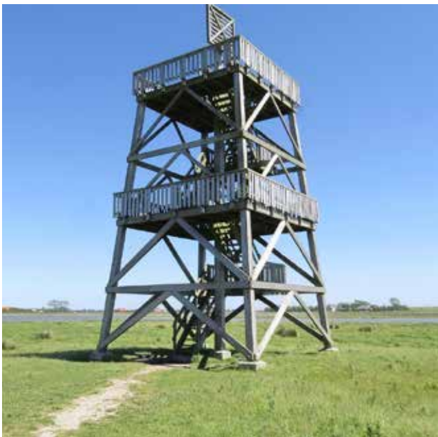
Uitkijktoren in de Prunjepolder
