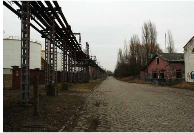
Petroleum Zuid - Foto: Thierry Hoornaert
