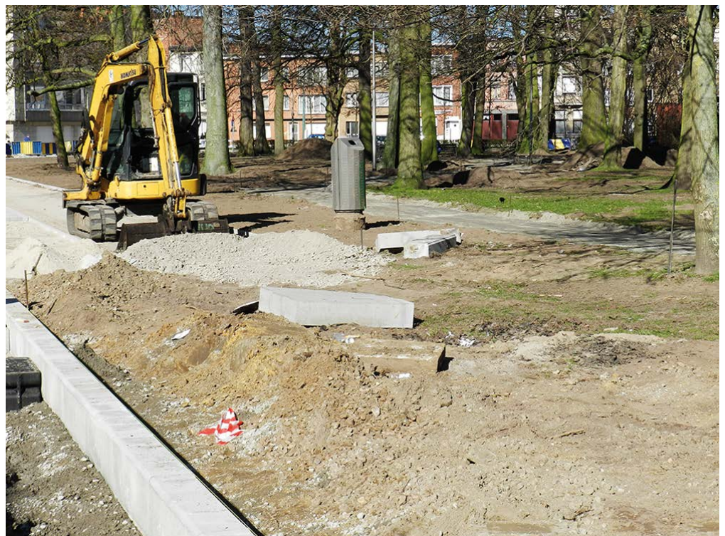
Van links naar rechts in aanleg: verbreed voetpad, fietspad 2,5 m breed (met rupsvoertuig). Rechts daarvan: 2 m breed wandelpad dat voor het eerst heel het park doorkruist
