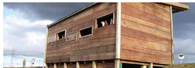
Kijkhut op Het Noordelijk Eiland Foto: ANB
