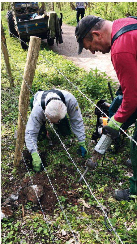
Gaten boren met de gehuurde boorhamer
